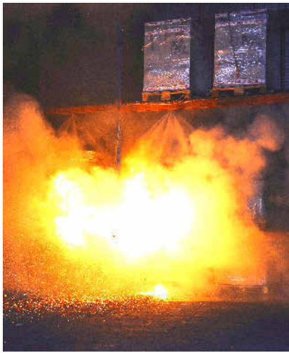
Bild 4 HDWN-Brandbekämpfungsanlage wird zur Eindämmung des Brandes verwendet. Foto: Fogtec
